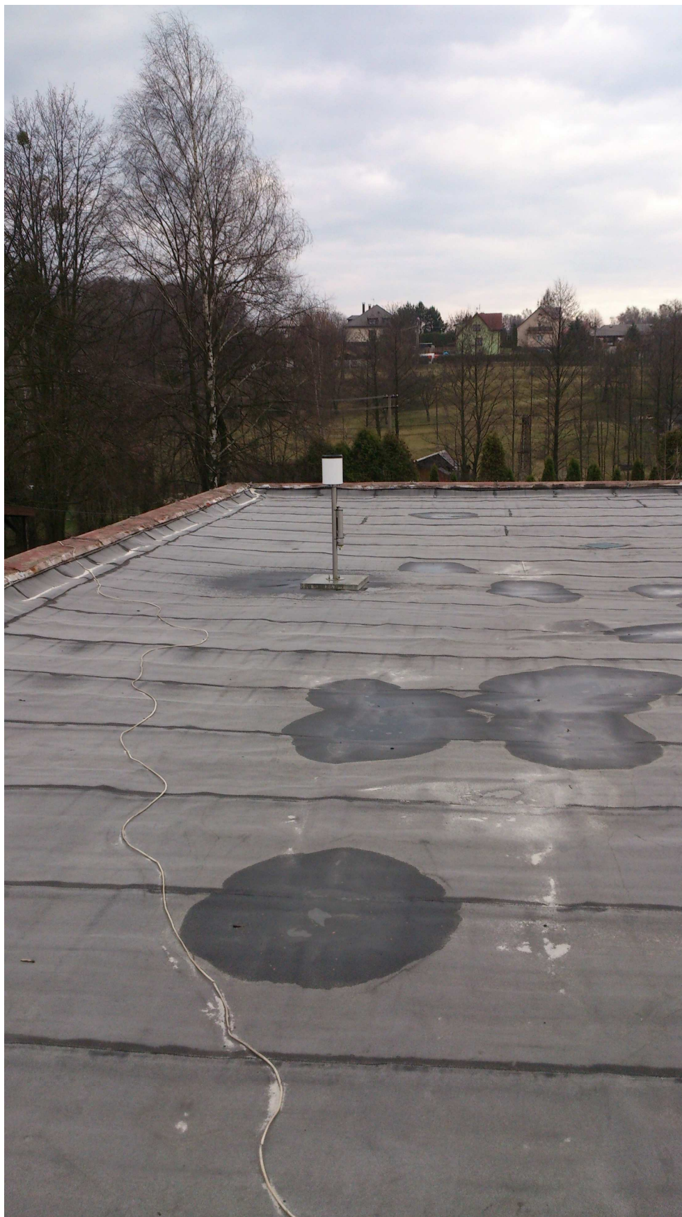
Nový srážkoměr umístěný na střeše Mateřské školy
