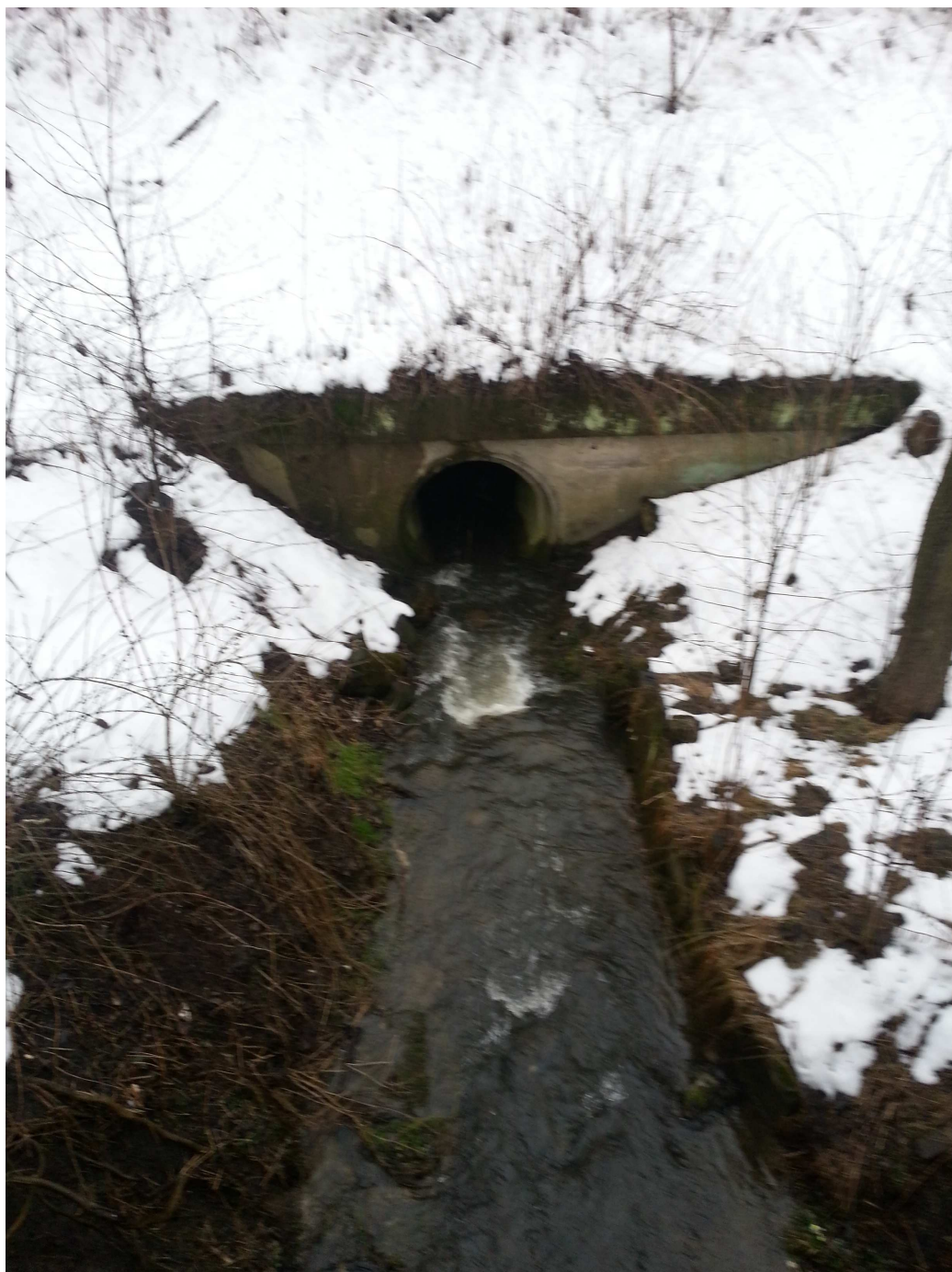
Pohled na silniční propustek na Podleském potoce pod ulicí Těšínská – místo omezující odtokové poměry
