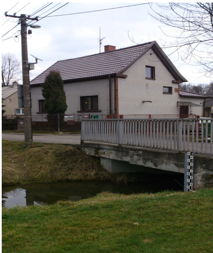
Propustek pod ulicí U Potoka s kanalizační šachtou – místo omezující odtokové poměry (směr po toku)
